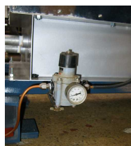
← 計装用空気をパージ 防爆対策のひとつとして、微量の 圧縮空気で盤内を正圧に保ちます。 ↓ 空気流量調整器
